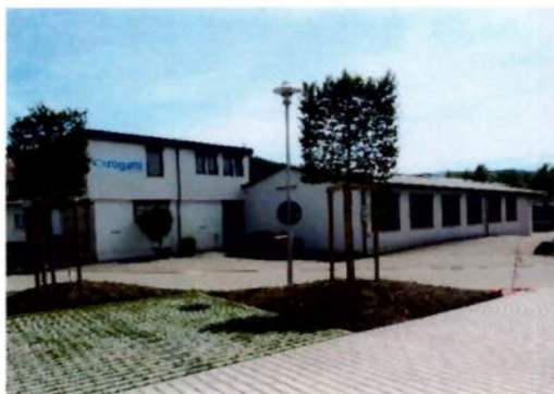
ehemaliges Verwaltungsgebäude mit Montagehalle (bis 2018)
