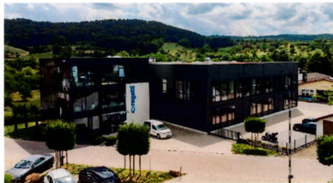
neues Verwaltungsgebäude mit Montagehalle (seit 2019)
